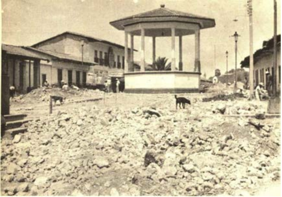
LOS TRABAJOS DE REMODELACION DE LA CABECERA AVANZAN A TODA VELOCIDAD Y MUY PRONTO PODRA EXHIBIR SU NUÉVA FAZ, MAS ACORDE CON LA VIDA PRESENTE.
